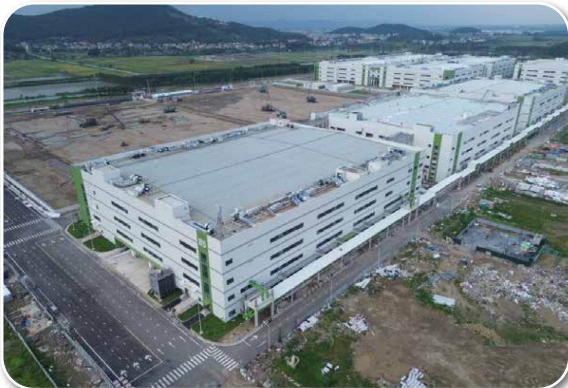
Nhà xưởng Goertek - KCN Nam Sơn, Hạp Lĩnh
