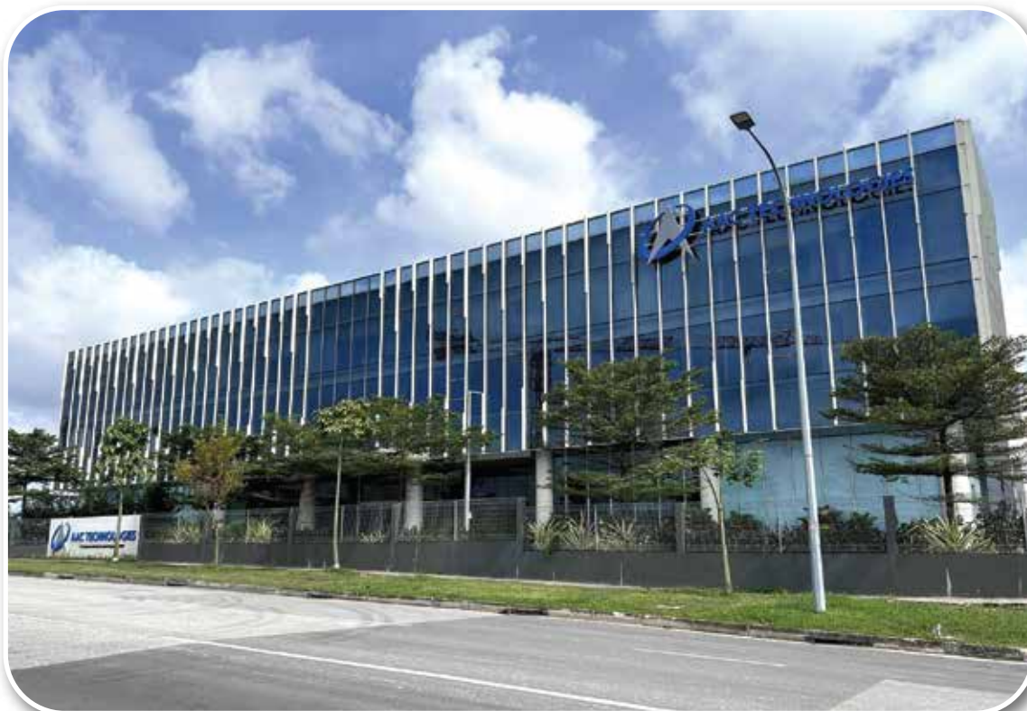
Nhà xưởng B,C – Công ty TNHH AAC Technologies - KCN Quế Võ 1, tỉnh Bắc Ninh
