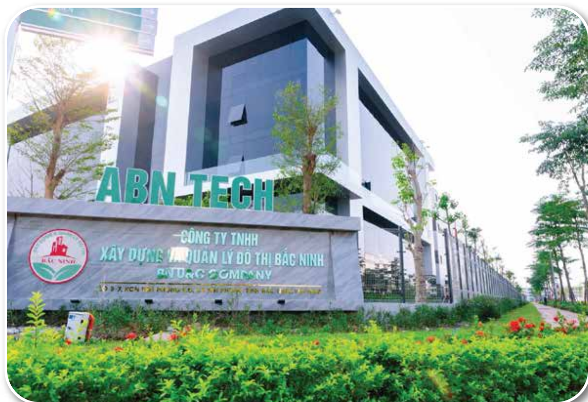
Nhà máy ABN Tech - Lô CN5-7, KCN Yên Phong 2C, xã Yên Phong, tỉnh Bắc Ninh
